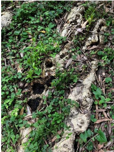
浮根、根系損傷
