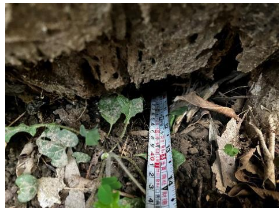
主幹、基部腐朽空洞
