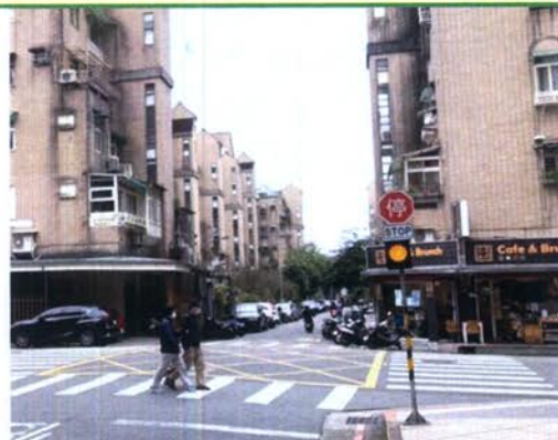
325巷5弄路口閃光設施
