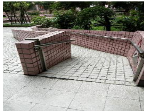
中庭無障礙坡道
