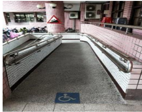
校門口無障礙坡道
